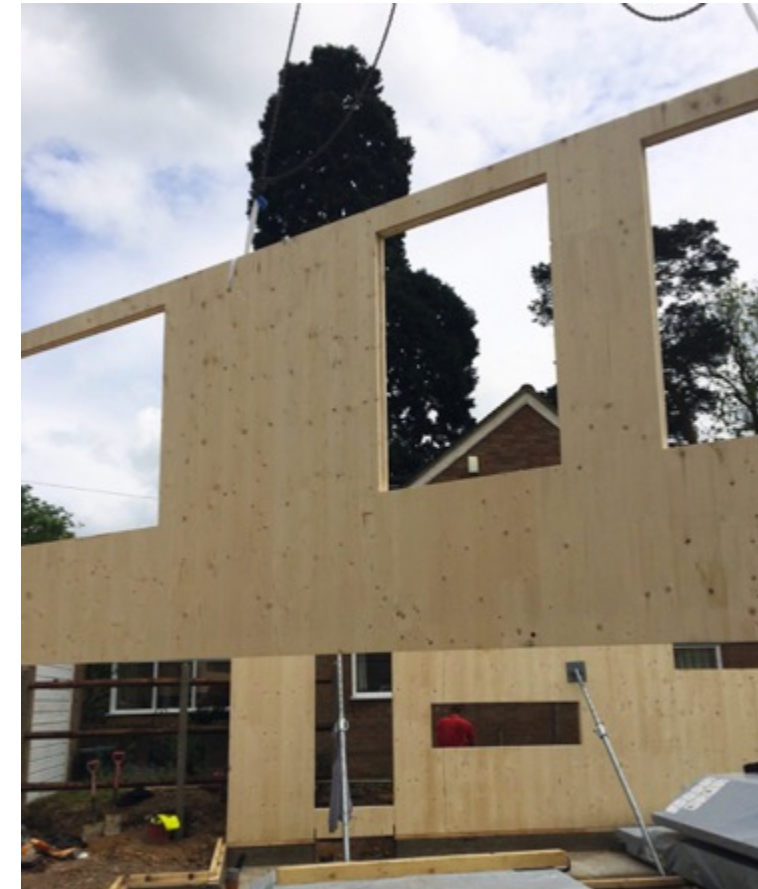
Image: Construkt CLT
